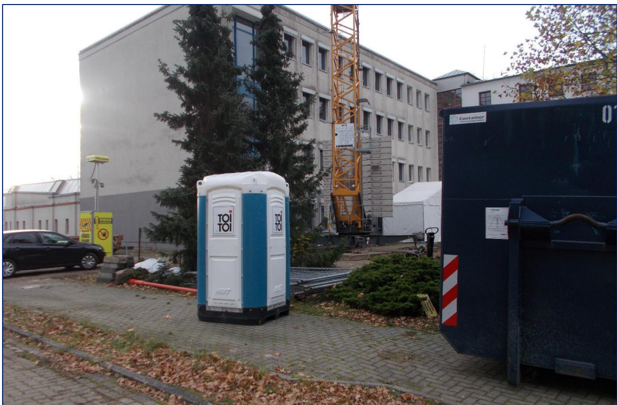
Abbildung 6: zu sanierendes Gebäude
