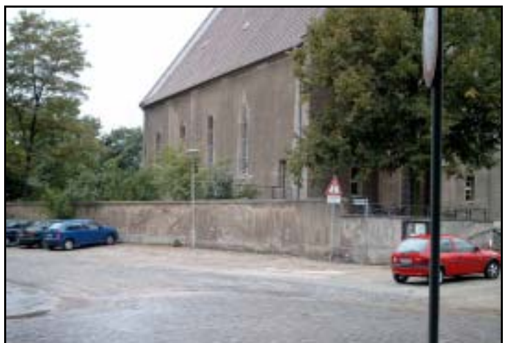
Kirchhofmauer an der Ostseite
