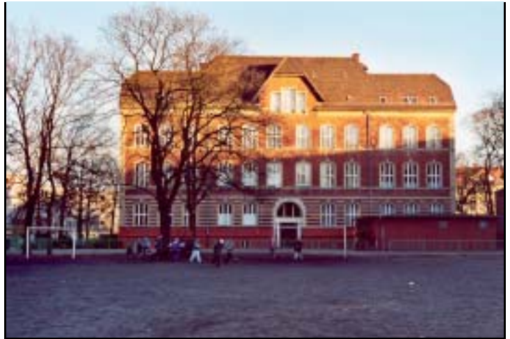
Schulgebäude mit An- bau (rechts)
