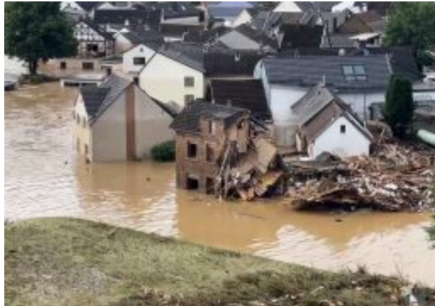
Schäden durch Starkniederschläge, Juli 2021
