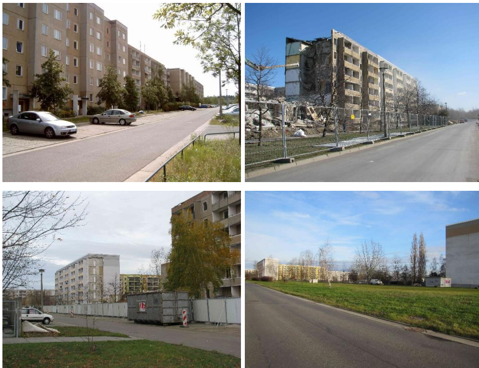
Abb. 5 - 8: Entwicklung des Bereiches Hutungstraße vor, während und nach dem Rückbau von 2007 bis 2012
