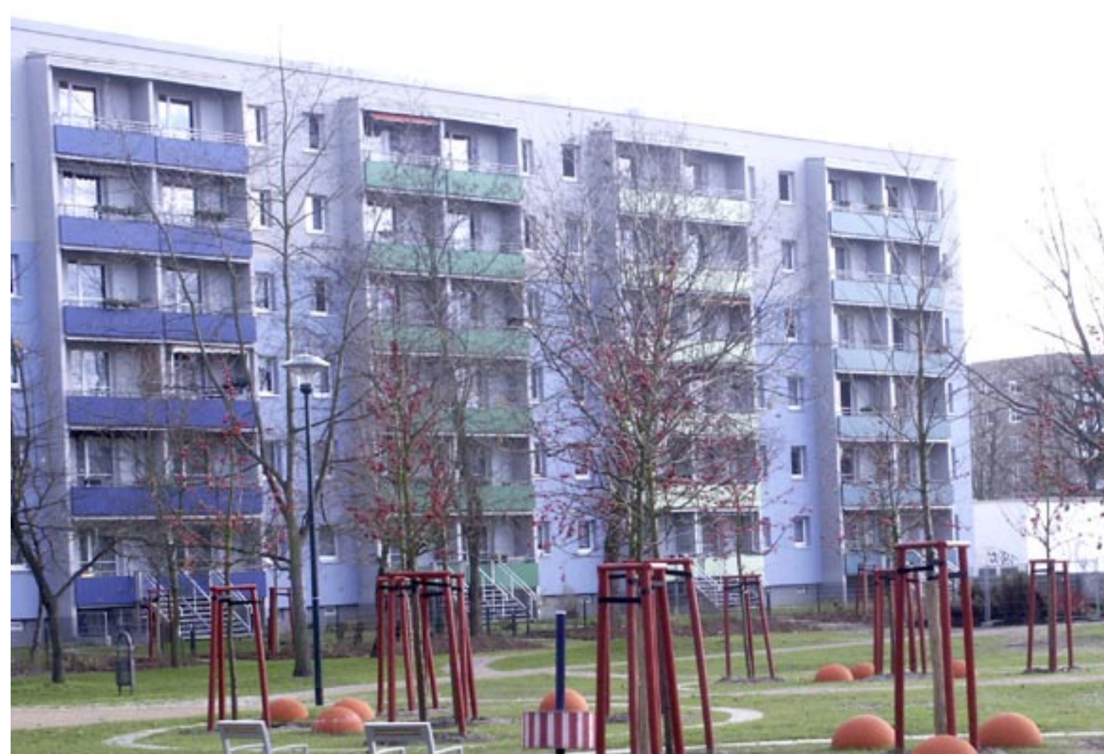
Sanierung von Wohngebäuden und Aufwertung des Wohnumfeldes, Quartier 2
