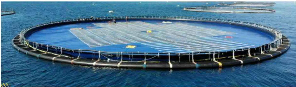
**Abbildung 5: Varianten von Unterkonstruktionen - Ringstruktur** | Quelle: <https://oceansun.no/benefits/#install>
