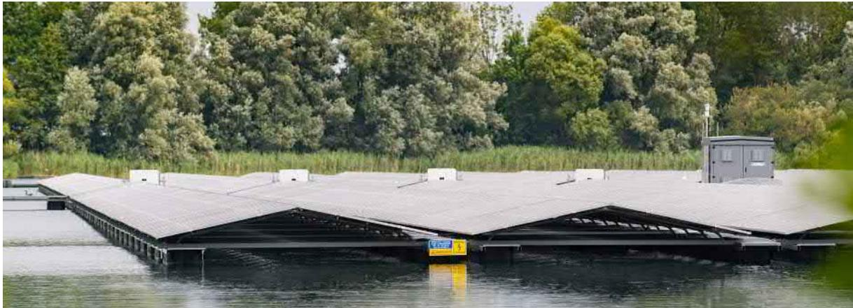
**Abbildung 4: Varianten von Unterkonstruktionen – Rechteckstruktur** | Quelle: Zimmermann PV Floating
