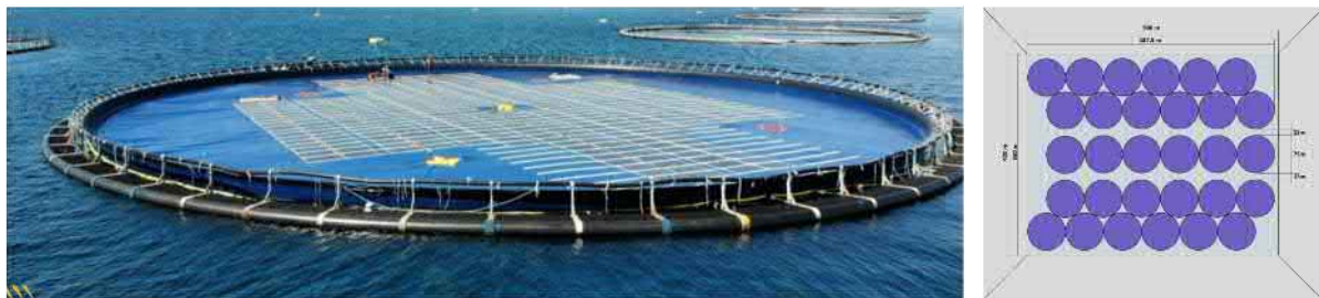
Abbildung 4: Beispielhafte Darstellung FPV-Anlage als Ringstruktur | Quelle: https://oceansun.no/benefits/#install
