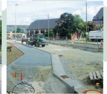
Umbau der Franz-Mehring-Straße, Sommer 2013
