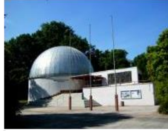
Modernisierung Planetarium (Fulldomeprojektions- Anlage in ZG) EFRE: 722.450,00 EUR
