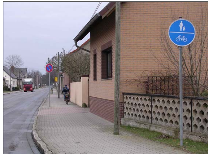
Bild 3-3: Dissencher Hauptstraße - Unterbrechung des Radwegbelages an Grundstückszufahrten
