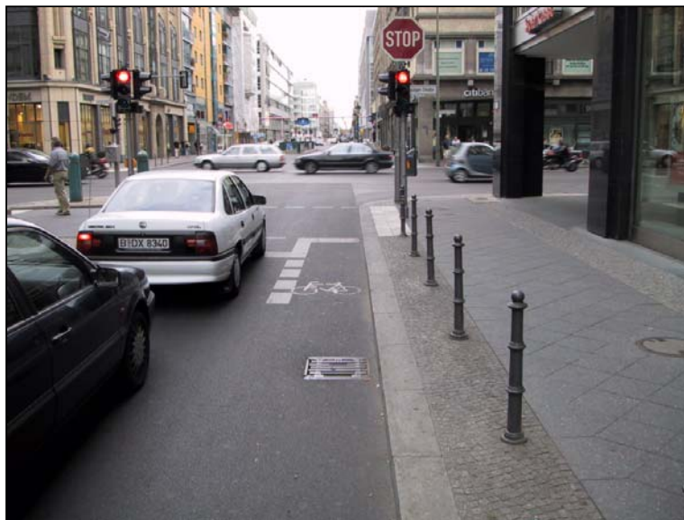
Bild 6-3: Vorbeifahrstreifen in einer signalisierten Knotenpunktzufahrt (Berlin)
