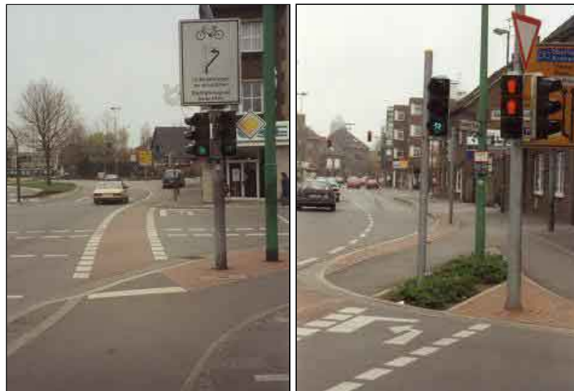
Bild 6-23: Anordnung der Aufstellfläche für indirektes Linksabbiegen und Vorankündigung mit Hinweisschild (links) sowie Anordnung eines speziellen Signals für indirekt linksabbiegende Radfahrer (rechts)
