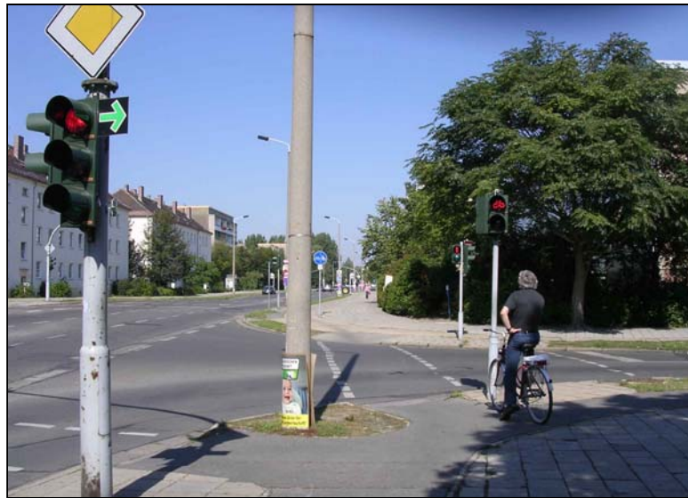
Bild 6-16: Eigener Signalgeber für den Radverkehr an einem kleineren Knoten im Zuge der Willy-Brandt-Straße – Freigabezeiten entsprechen denen der Fußgängersignalisierung
