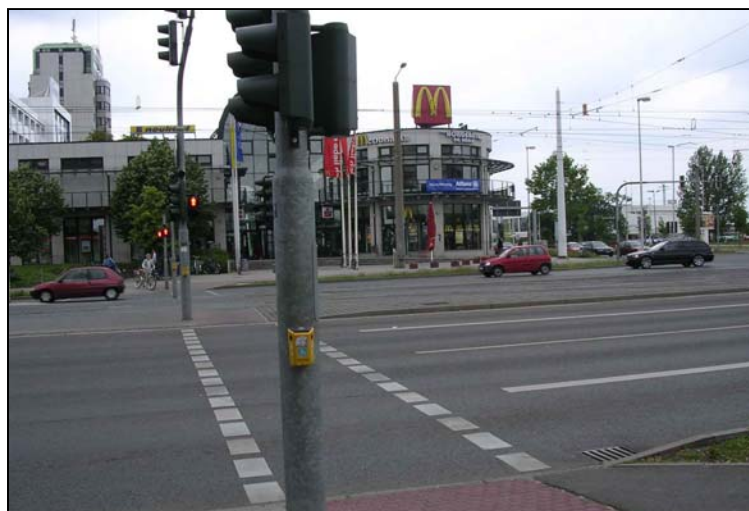
Bild 6-8: „Starre Schiene“ mit sehr weit abgesetzten Furten am Knoten Stadtring/Thiemstraße
