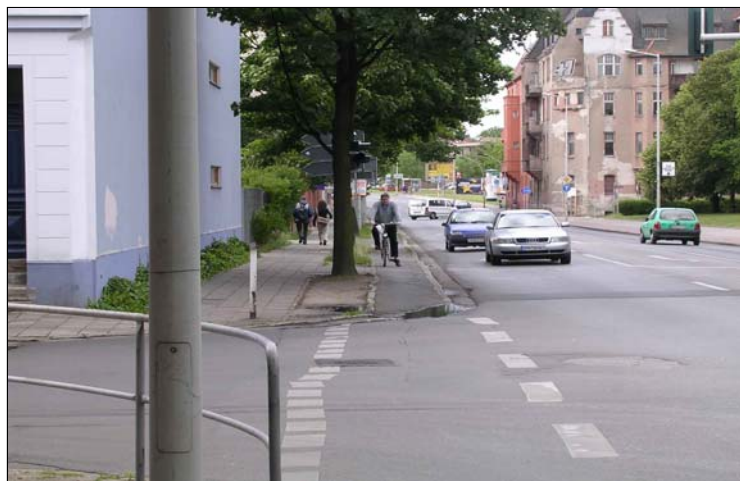
Bild 6-9: Unzureichende Bordabsenkungen im Zuge des Radweges an der Karl-Marx-Straße
