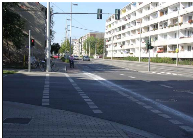
Bild 6-10: Gut ausgebildete Bordabsenkung im Zuge des Radweges an der Berliner Straße
