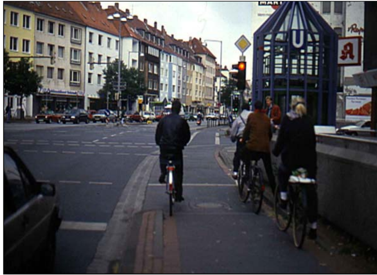
Bild 6-2: Nicht abgesetzte Radwegführung und Radfahrtsignal mit Grünvorlauf an einem hochbelasteten Knotenpunkt (Hannover)
