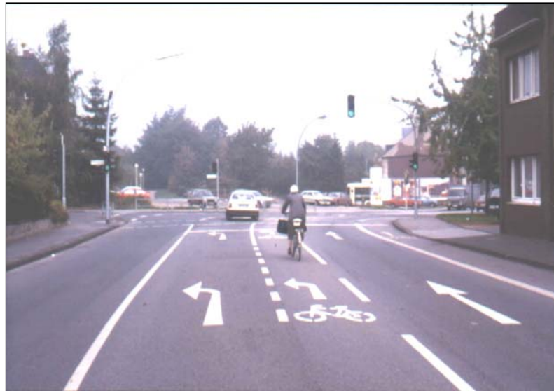
Bild 6-24: Schutzstreifen zum direkten Linksabbiegen innerhalb eines Linksabbiegestreifens
