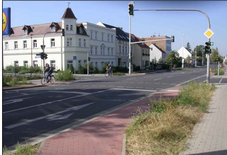
Bild 6-7: Neuer Radweg mit Heranführung an die Fahrbahn (Karl-Liebknecht-Straße)
