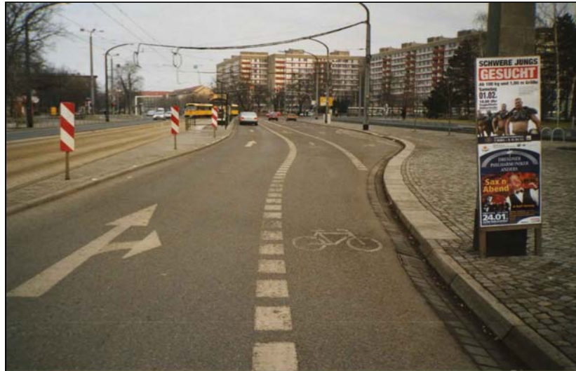
Bild 6-4: Radfahrstreifen für geradeausfahrende Radfahrer an einem Knotenpunkt mit Rechtsabbiegefahrbahn (Dresden)
