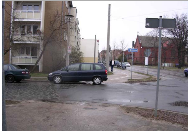
Bild 6-11: Fehlende Furtmarkierung im Zuge der Karlstraße
