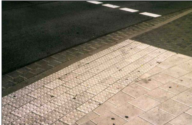
Bild 6-20: Noppenplatten als Aufmerksamkeitsfeld beim Übergang eines Geh- und Radweges auf die Fahrbahn
