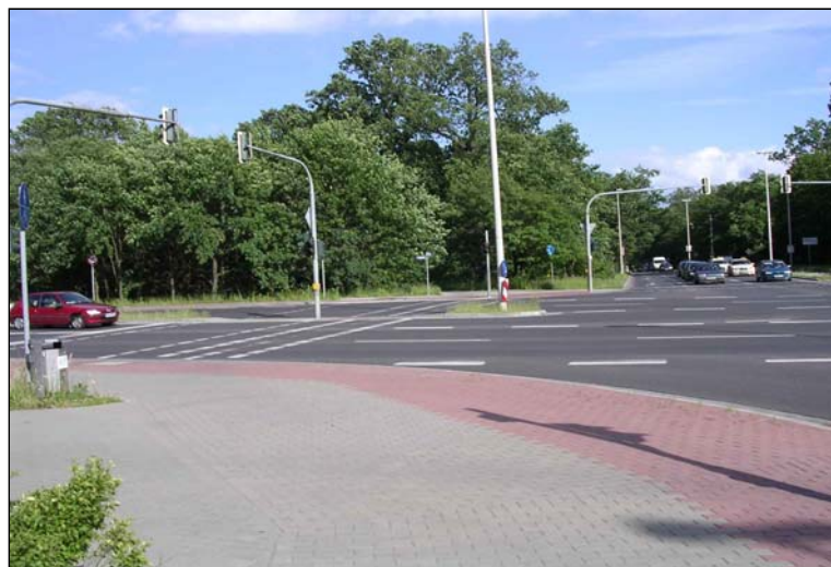
Bild 6-15: Starre Schiene mit abgesetzter Führung im Zuge eines neuen Radweges (Stadtring/Willy-Brandt-Straße)
