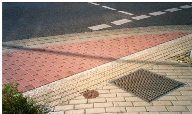
Bild 6-19: Radwegabsenkung in Standardbauweise (Karl-Liebknecht-Straße)
