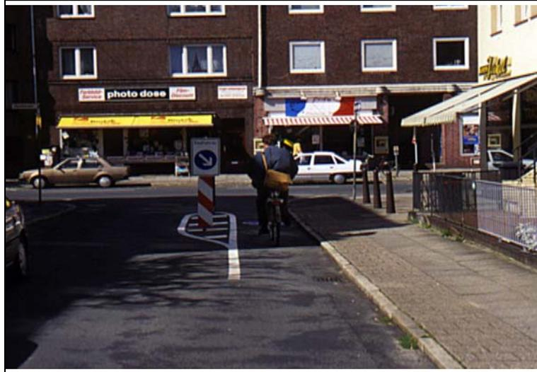
Bild 7-5: Baulich getrennter Ausfahrtbereich für den gegengerichteten Radverkehr am Übergang zu einer bevorrechtigten Straße (Bremen).
