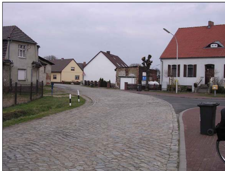
Bild 5-23: Schlichower Dorfstraße – sehr unebenen Pflasterbelag
