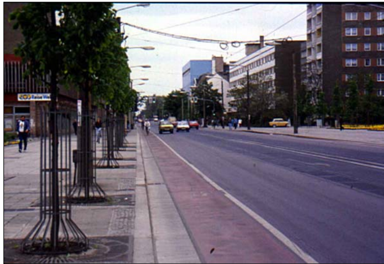
Bild 5-5: Überbreite Richtungsfahrbahn mit Radfahrstreifen (Dessau)
