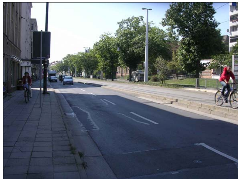
Bild 5-11: Straße der Jugend südlich des Stadtringes
