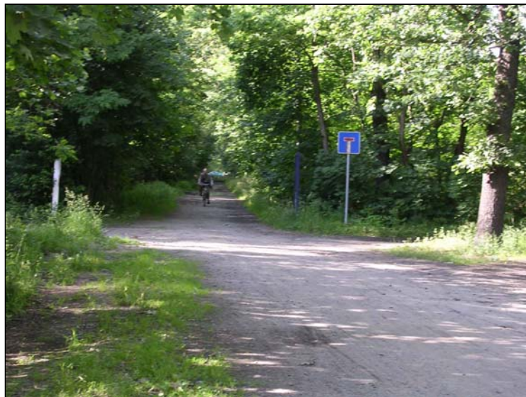
Bild 5-27: Unzureichende Belagsqualität im Zuge der selbständigen Wegeverbindung der Tierparkstraße
