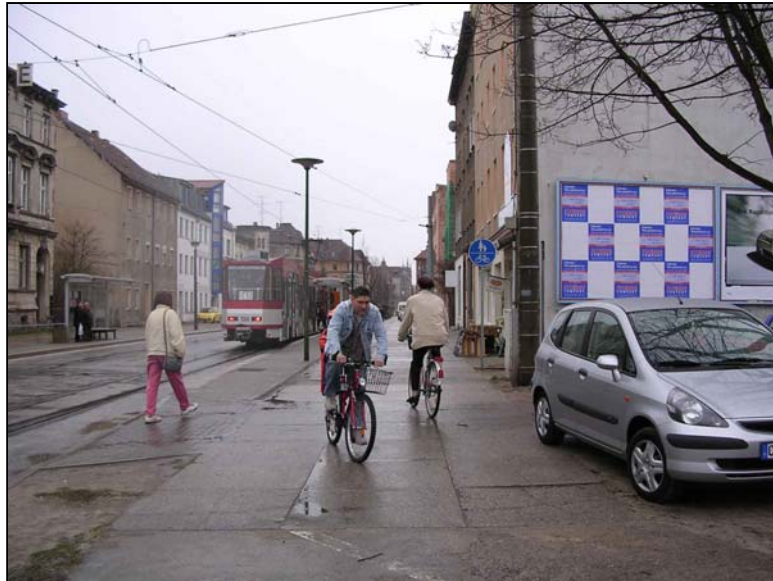
Bild 5-15: Karlstraße – gemeinsamer Geh- und Radweg mit älteren Betonplatten. Im Bereich der Haltestelle können potenziell Konflikte mit wartenden bzw. ein- oder aussteigenden Fahrgästen erfolgen
