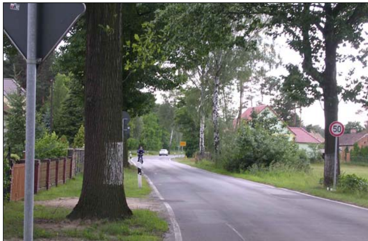
Bild 5-29: Fehlender Radweg (auch im Zuge der Schulwegsicherung erforderlich) Karlshofer Straße
