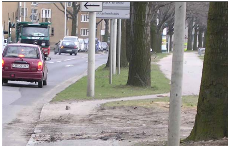
Bild 5-9: Sielower Landstraße –nördlich Friedrich-Ludwig-Jahn Schwimmstadion, ank. Radweg ohne Sicherheitstrennstreifen zur Fahrbahn bei unzureichender Breite
