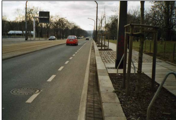
Bild 5-3: Schutzstreifen in einer Straße mit Mitteltrennung (Dresden)
