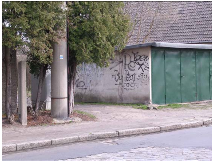
Bild 5-21: Fehle Absenkung bei der Querung einer Wegeverbindung über eine Straße (Ströbitzer Straße)
