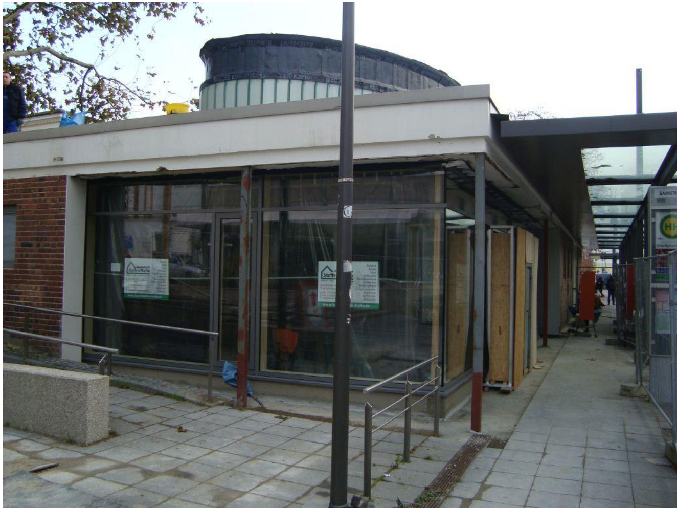
Das neue Kundenzentrum von Cottbusverkehr
