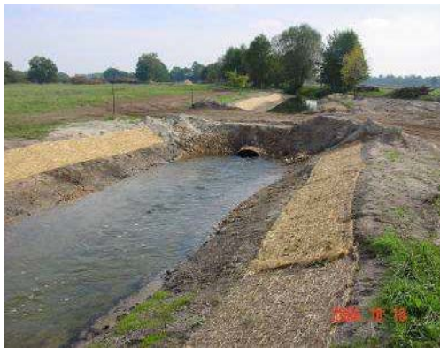
Abb. 6 Böschungssicherung [42]
