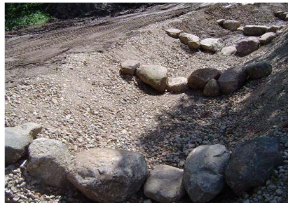
Einbau der Sohlgleite
