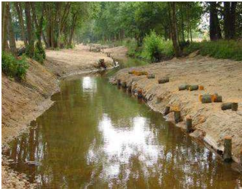
Abb. 2 Einbau wechelseitiger Buhnen [38]
