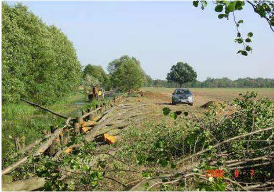
Fäll- und Rodungsarbeiten [4]
