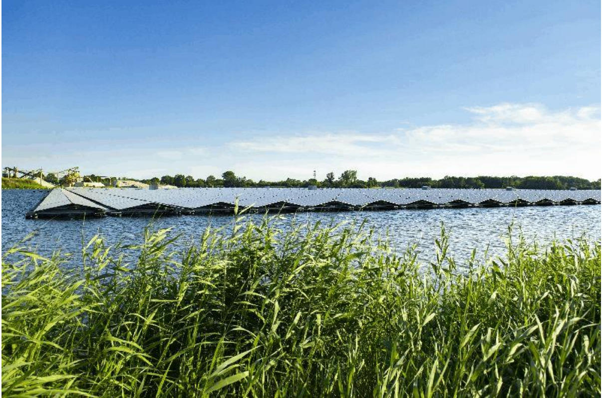
Bild 1: Solaranlage 1 (technischer Überblick)
