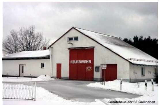
Gerätehaus der FF Gallinchen
