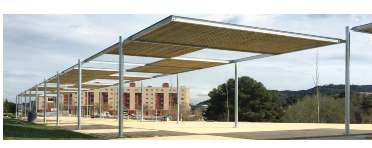
Überdachungselemente als Schattenspendler
